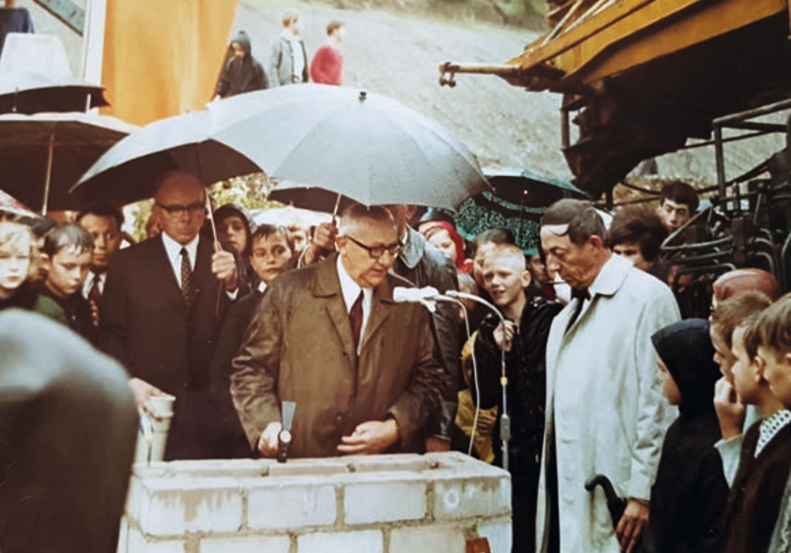
Karl Maurer, der damalige Bürgermeister der Stadt Eiserfeld, beging am 27. September 1969 mit den drei traditionellen Hammerschlägen die Grundsteinlegung zum Bau der Richerfeldschule.
