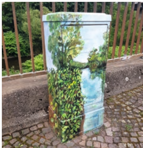
Einmündung Bühlsstraße / Siegtalstraße
