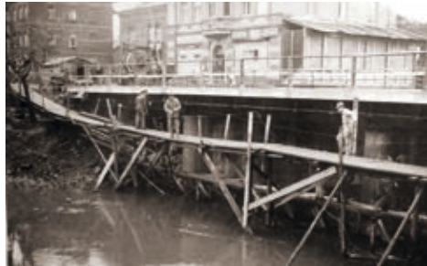
Bilder vom Wiederaufbau der Häuser und der Siegbrücke. Das rechte Bild zeigt einen errichteten Notsteg für Fußgänger über die Sieg.
