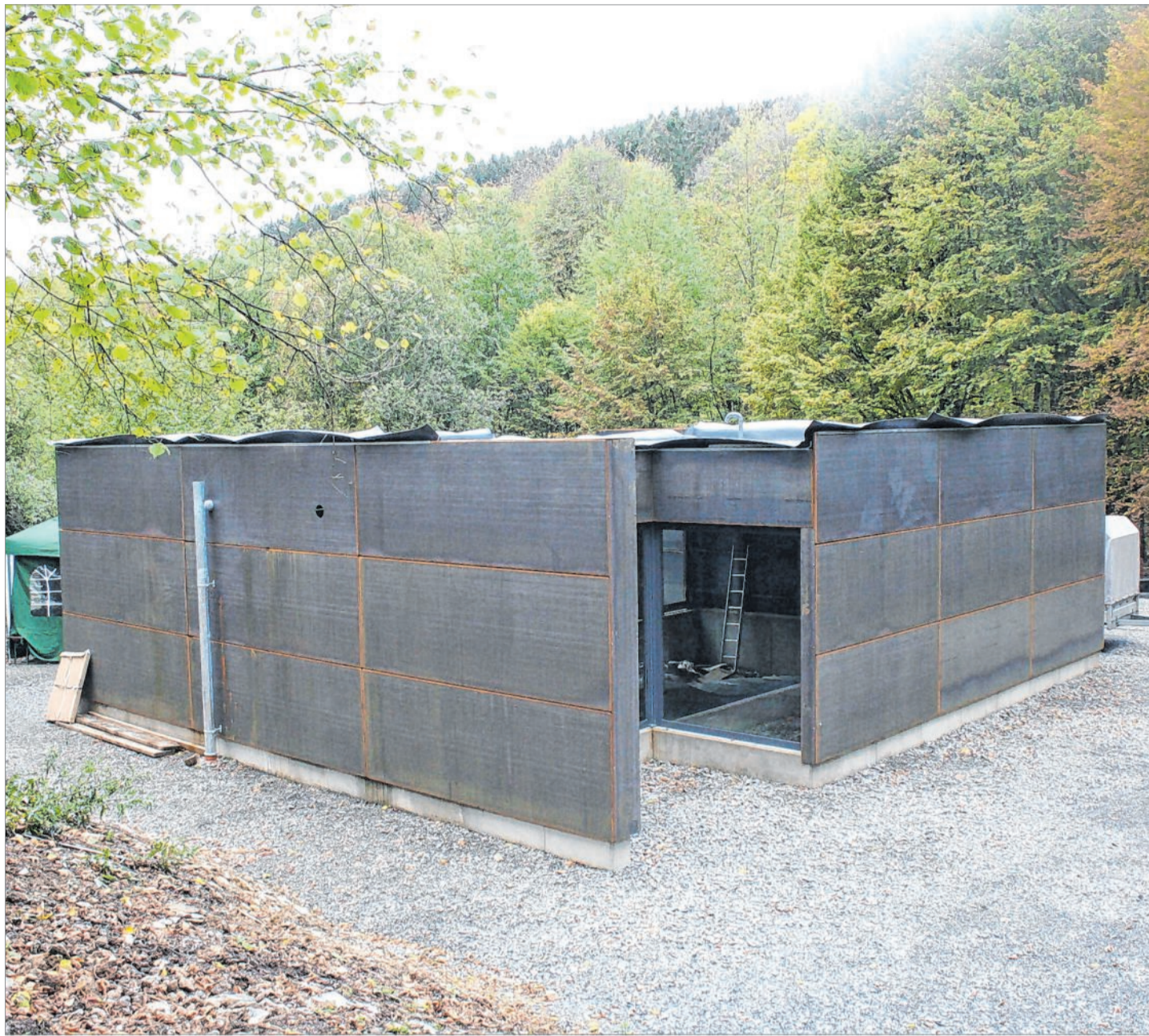
Ein bisschen Bauhaus im Schelder Wald: Der Schutzbau für die Ausgrabungsstätte „Gerhardsseifen“ besteht komplett aus Corten-Stahl – wie könnte es auch anders sein? Fotos: thor
